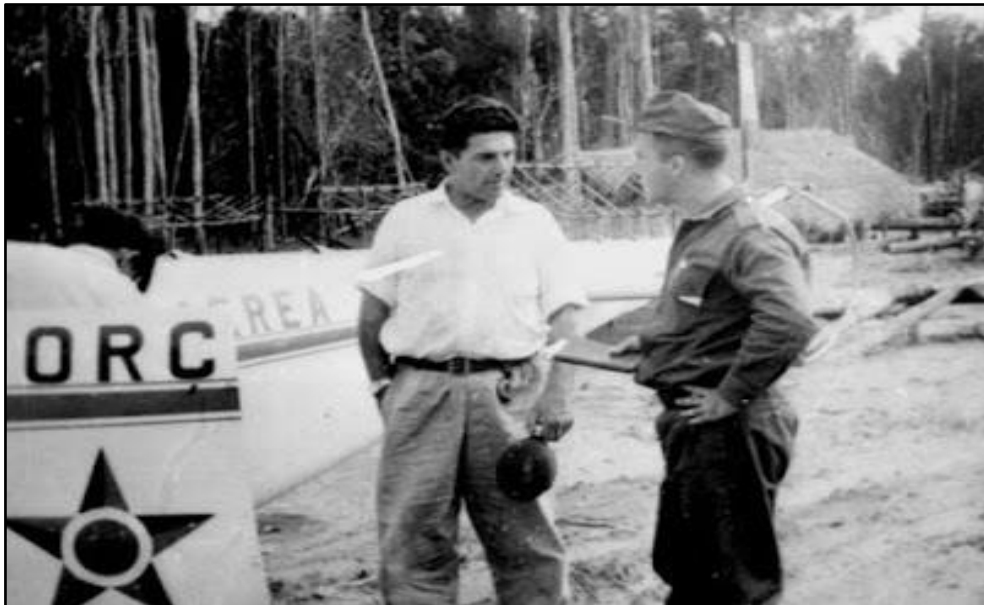
Figura 8: Eng. Bernardo Sayão acompanhando as obras da BR-010.
